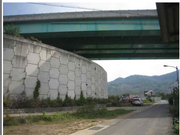
교량 하부 옹벽 전경
