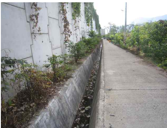
하부 배수로 전경
