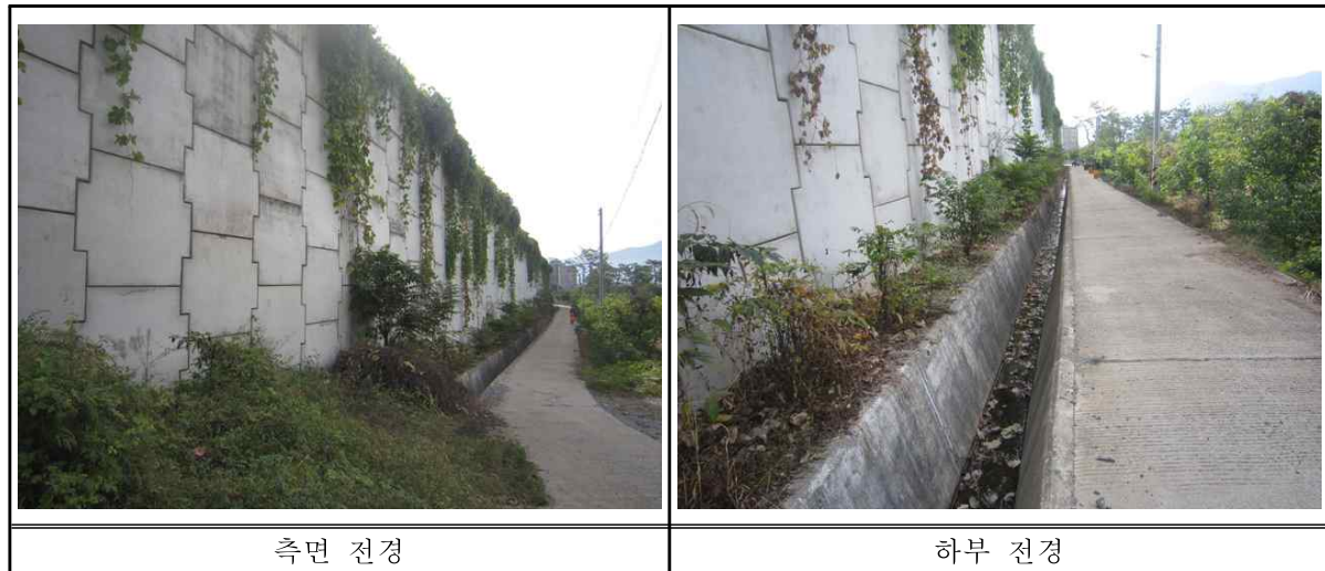
<그림 1.1.1> 보강토옹벽(4공구) 전경
